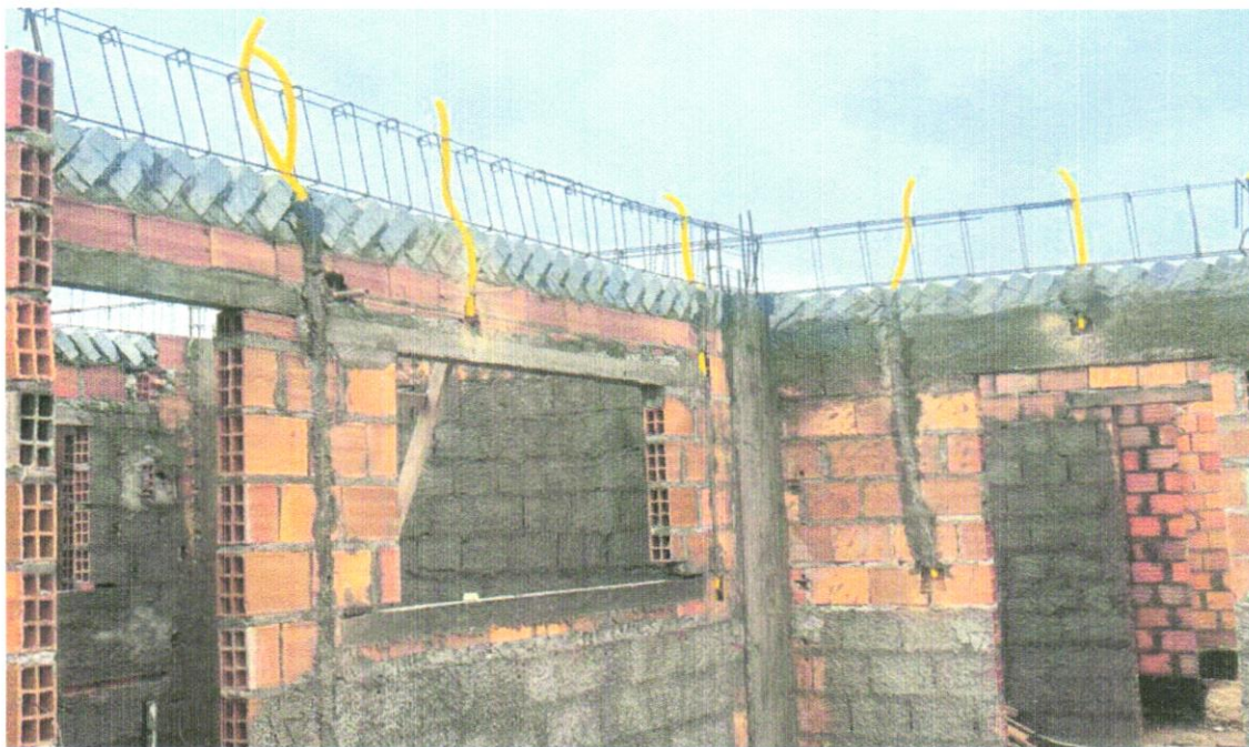
FOTO 54 – Eletroduto PVC flexível corrugado reforçado, Ø32mm (DN 1"), inclusive conexões
