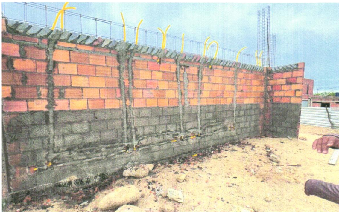
FOTO 54 – Eletroduto PVC flexível corrugado reforçado, Ø32mm (DN 1"), inclusive conexões
