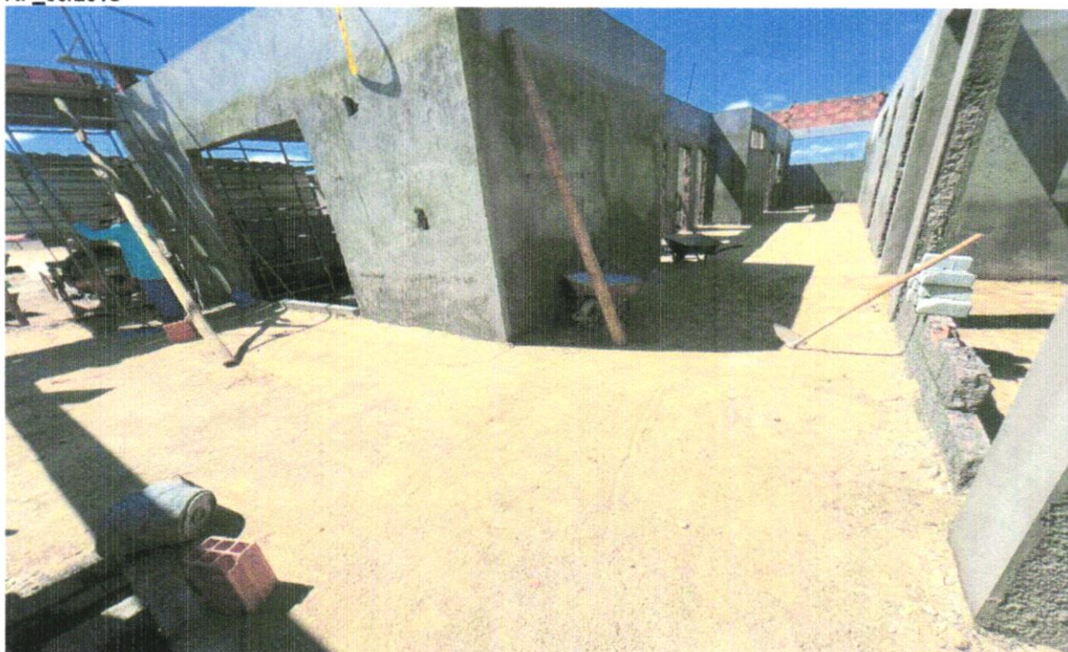
FOTO 60 – ATERRO MANUAL DE VALAS COM SOLO ARGILO-ARENOSO E COMPACTAÇÃO MECANIZADA. AF_05/2016
