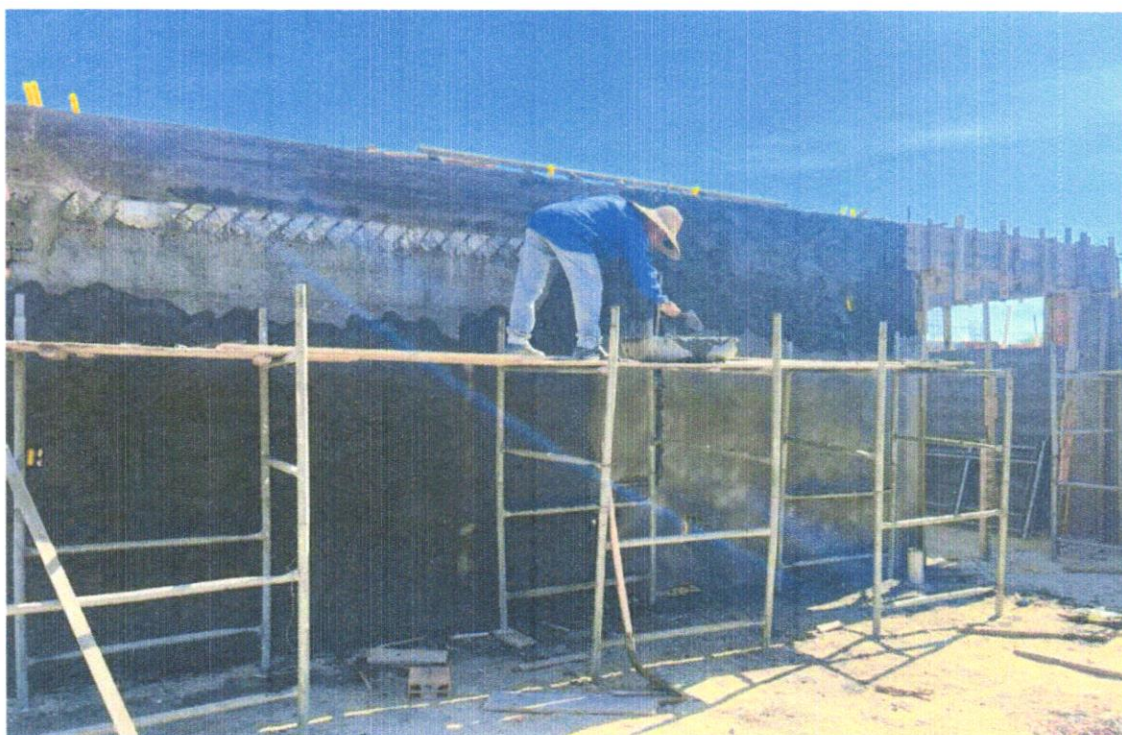
FOTO 30 – Emboço para paredes internas traço 1:2:9 - preparo manual - espessura 2,0 cm
