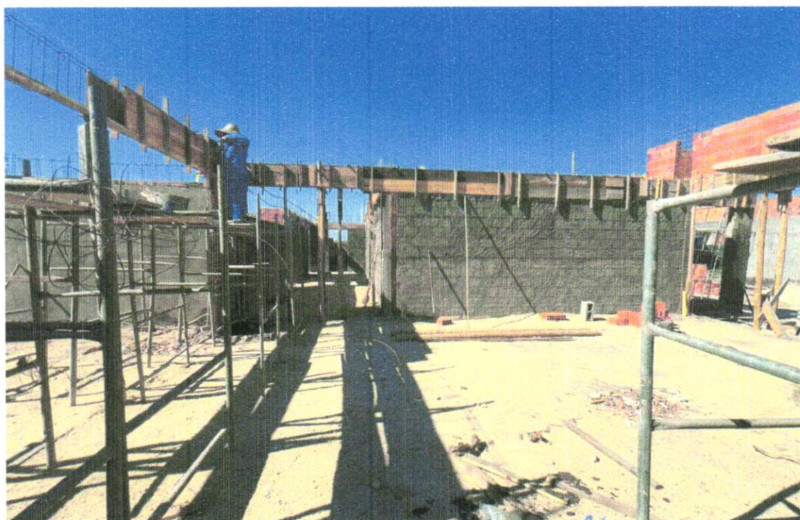
FOTO 06 - MONTAGEM E DESMONTAGEM DE FÔRMA DE VIGA, ESCORAMENTO COM GARFO DE MADEIRA, PÉ-DIREITO SIMPLES, EM CHAPA DE MADEIRA PLASTIFICADA, 12 UTILIZAÇÕES. AF_09/2020
