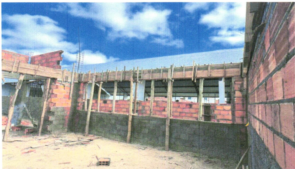
FOTO 04 – MONTAGEM E DESMONTAGEM DE FÔRMA DE VIGA, ESCORAMENTO COM GARFO DE MADEIRA, PÉ-DIREITO SIMPLES, EM CHAPA DE MADEIRA PLASTIFICADA, 12 UTILIZAÇÕES. AF_09/2020
