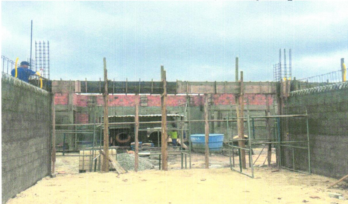
FOTO 05 - MONTAGEM E DESMONTAGEM DE FÔRMA DE VIGA, ESCORAMENTO COM GARFO DE MADEIRA, PÉ-DIREITO SIMPLES, EM CHAPA DE MADEIRA PLASTIFICADA, 12 UTILIZAÇÕES. AF_09/2020
