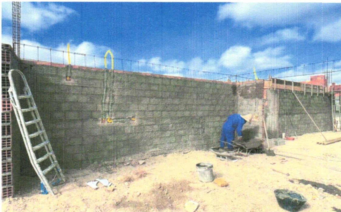
FOTO 30 – Emboço para paredes internas traço 1:2:9 - preparo manual - espessura 2,0 cm
